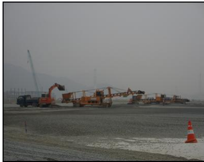
② Rubble Mat-1, 0.8m
