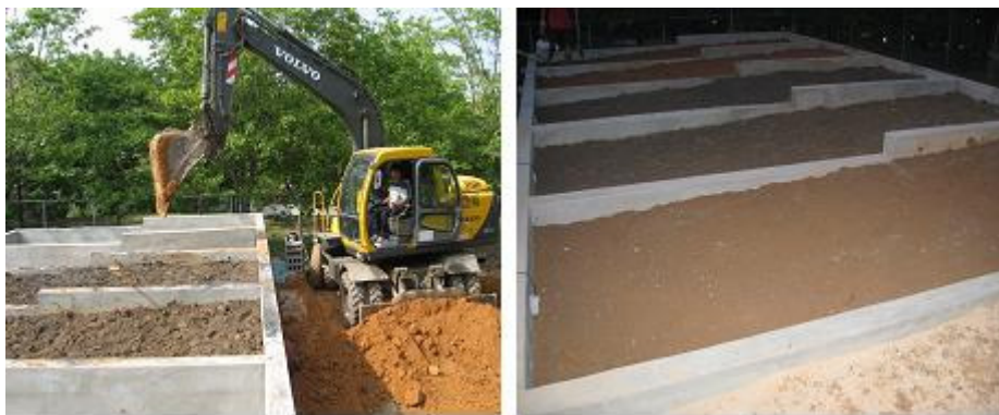
그림 6. 토조 내 복토재료 충전 전경
