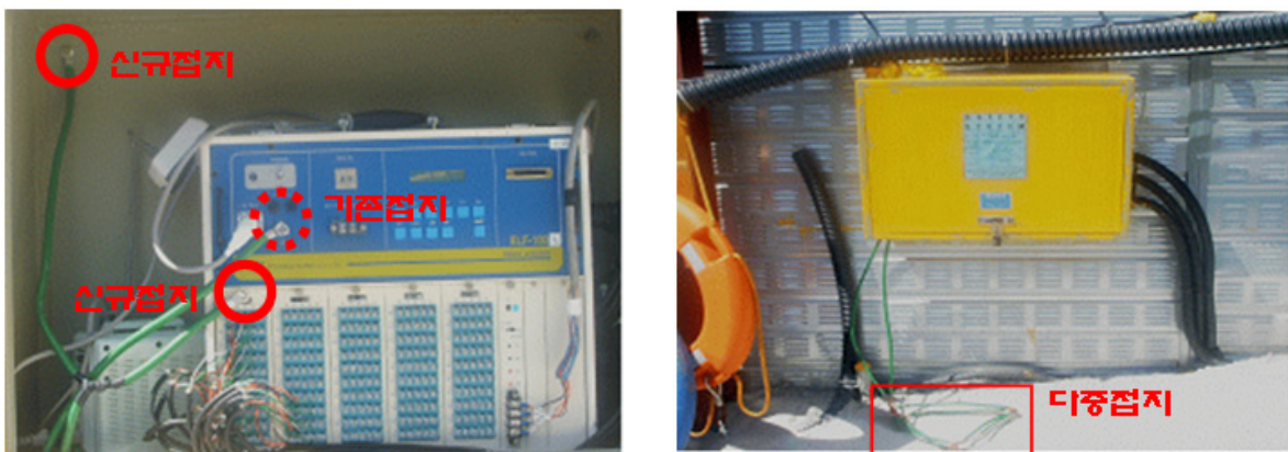
그림 4.3 Noise 소거를 위한 Field Logger 접지방식 개선
