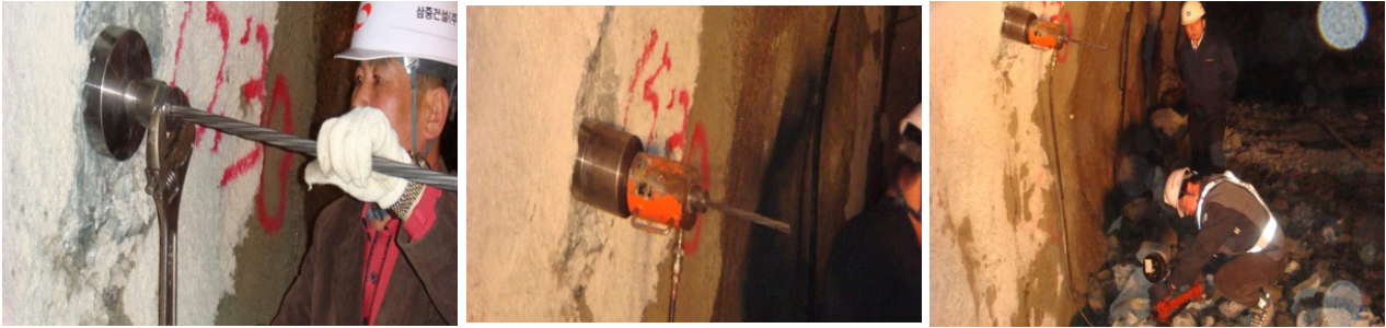
(a) 충전 및 보강재 설치
