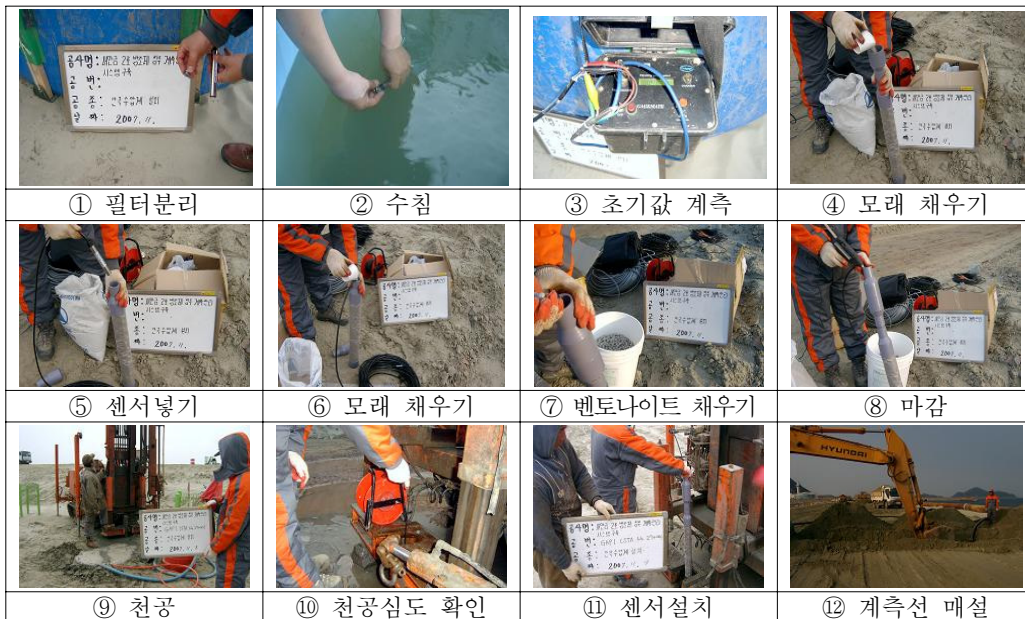
그림 2. 계측기 설치 순서(간극수압계)
