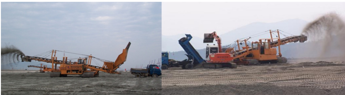
그림 9. 벨트 컨베이어를 이용한 포설공법 예
