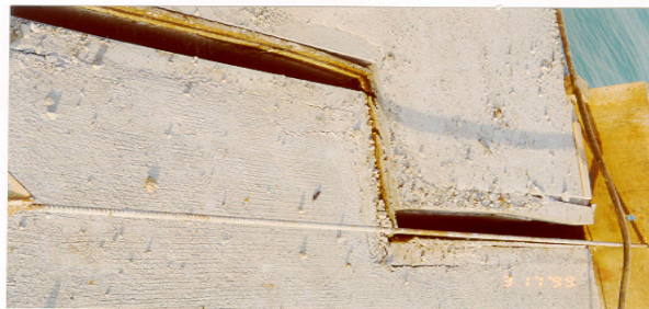
(b) Key Joint 변위상황 그림 4. 케이슨 변위 현황
