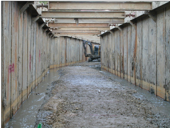
〈사진1〉 열연강판 시공상황
