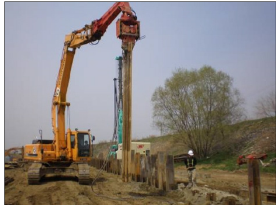
〈사진2〉 열연강판 근입(water jet 병행)
