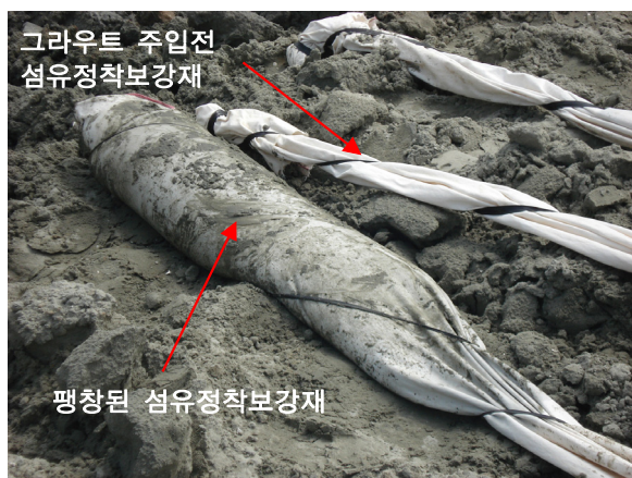
그림 3. 포대형상의 섬유정착보강재(자켓) 사진
