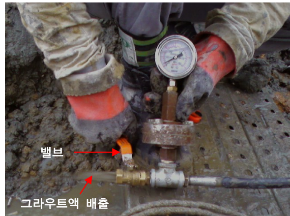
그림 4. 압력조절시스템(압력 게이지)
