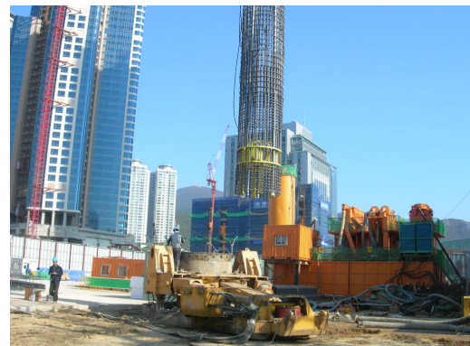
(c) Test Pile-1 시공전경
