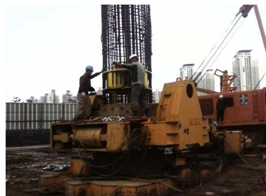
(d) Test Pile-2 시공전경
