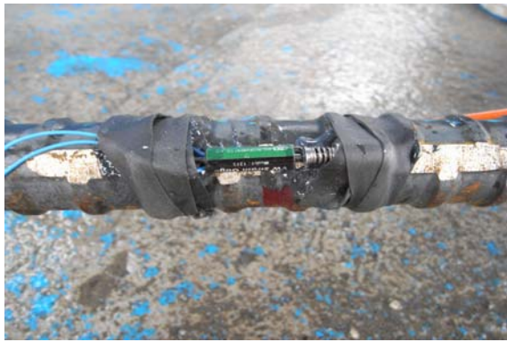
(c) 스트레인게이지 설치
