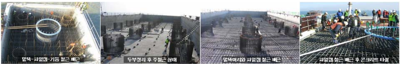
그림 1. 해상 다주식 기초에서 현장타설말뚝과 파일캡의 연결 시공 사진
