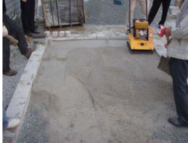
(e) 상부층 시공
