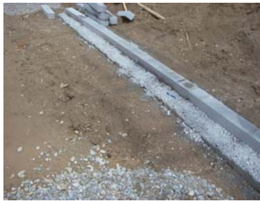
(b) 경계석 시공
