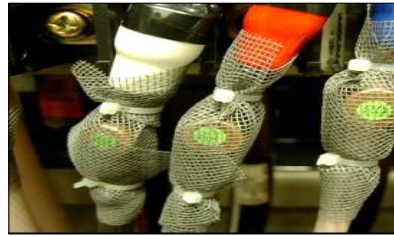
(b) 케이블 헤드에 망을 이용한 설치
