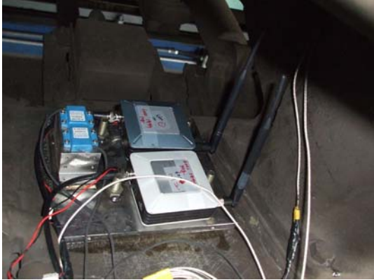
그림 11. 가속도계 및 무선계측기 설치 광경
