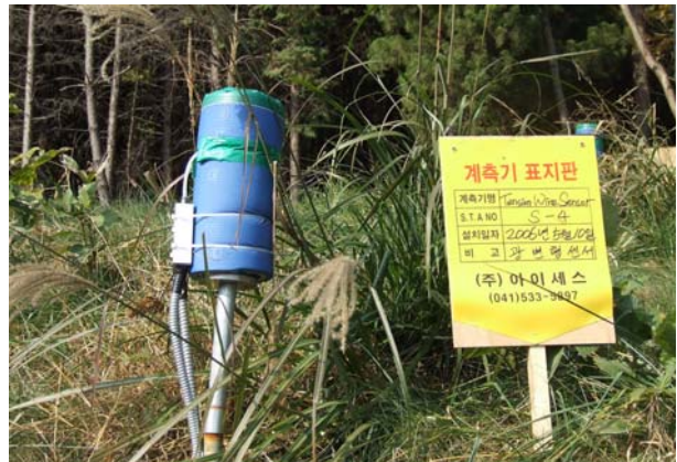
<그림 11> 광섬유 Tension Wire 설치 사진
