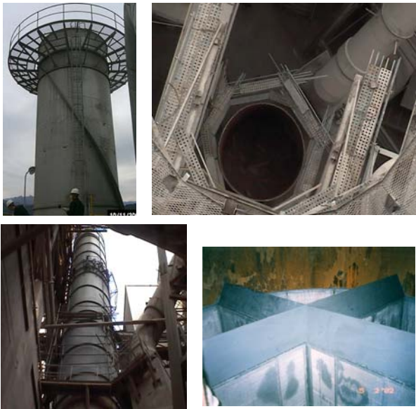
<Fig3.8 시공 및 설치 후 사진>
