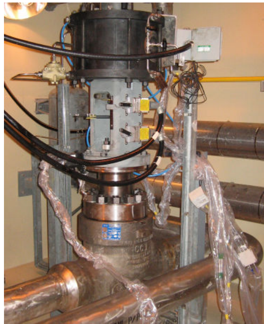
그림 3 원자력발전소 공기구동밸브 진단시험
