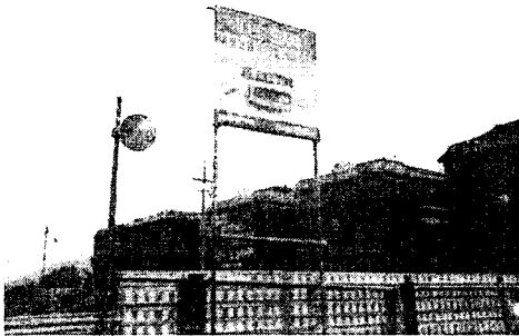
(c) 소음자동측정기의 공사현장 설치모습 그림 1. 소음자동측정기의 구성 및 설치 모습
