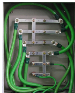
<그림 3> 접지단자(1종+2종+특3종 공결, 3종별도)-독립접지
