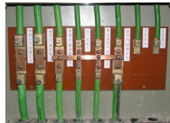
<그림 1> 접지단자(1종+2종 공결, 3종별도)-독립접지
