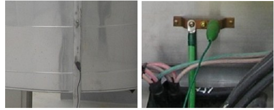
(b) 환기배관(측정점) (c) 접지단자 <그림 6> 계통외 도전성 부분의 연속성 측정(환기배관, 접지단자)
