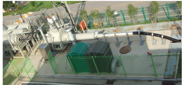
〈그림 1〉 초전도케이블 시스템 전원측 단말 전경
