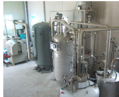
〈그림 2〉 증발식 냉각시스템
