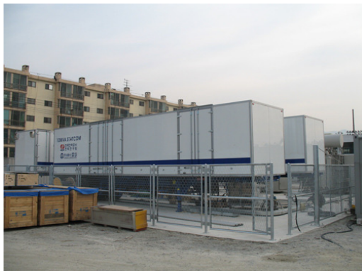
〈그림 5〉 10MVA STATCOM 설치 현장
