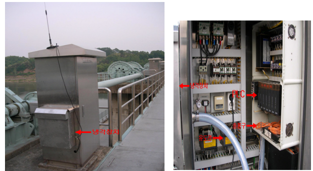
<그림 3> 냉각장치 현장 설치 사진
