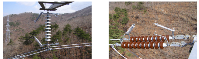
<그림 1> 154kV 송전선로용 피뢰기
