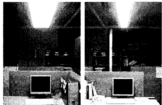
그림 4. LED(좌)와 형광등(우) 조명기구의 설치모습 Fig. 4. Installation scenes of LEDs and dimming FL
