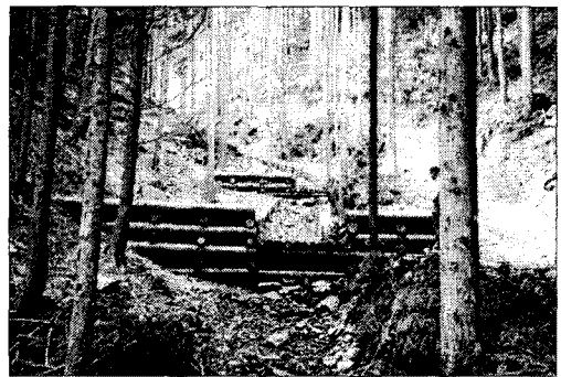
사진 6. 산불 피해목을 이용한 골막이 시공
