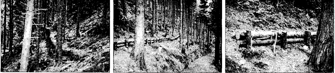
사진 4. 격심지구에 설치한 섯다밭공과 목책공의 시공 상황
