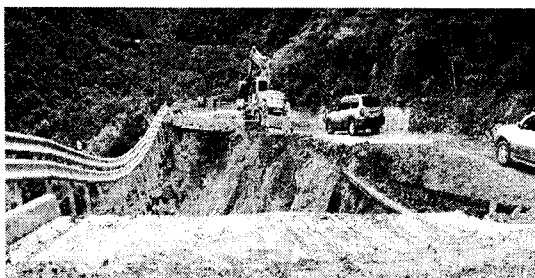
그림 4. 편절편성 구간의 성토비탈면 유실 사례
