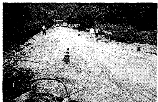
그림 7. 유송잡물에 의한 배수기능 저하에 따른 도로유실 사례
