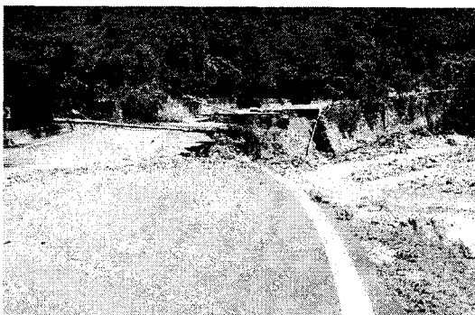
그림 6. 하천 수충부에서의 도로유실 사례
