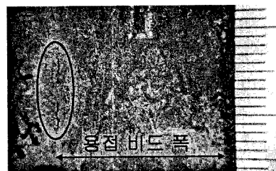
그림 2. 비파괴검사(MPT)로 검사된 균열
