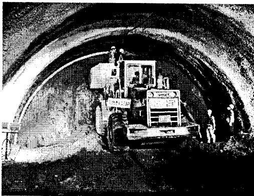
c) 강지보 설치
