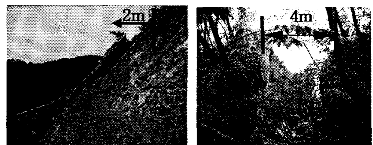
(a) 파괴사면 수평이동 (b) 상부 인장균열
