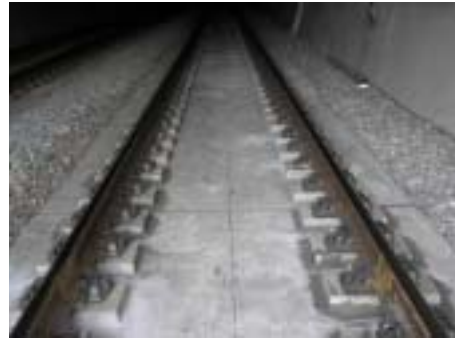
b. 임실터널 콘크리트 슬래브궤도
