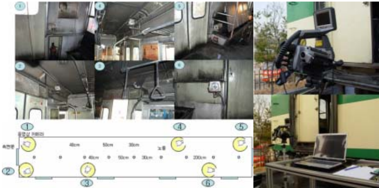
그림 6. 객차 내 CCTV 및 적외선 카메라 설치
