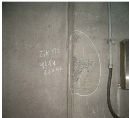
그림 2.7 박리(21K164 : RW) 그림 2.8 재료분리(21K172 : RW) 그림 2.9 철근노출(21K174 : LS)
