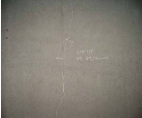
그림 2.5 횡방향 균열(cw 0.1~0.2, 21K178 : LW) 그림 2.6 횡방향 균열(cw 0.1~0.2, 21K209 : RW)
