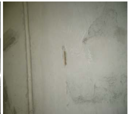
그림 2.7 박리(21K164 : RW) 그림 2.8 재료분리(21K172 : RW) 그림 2.9 철근노출(21K174 : LS)
