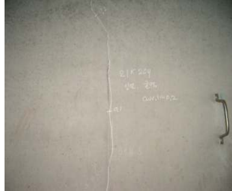
그림 2.5 횡방향 균열(cw 0.1~0.2, 21K178 : LW) 그림 2.6 횡방향 균열(cw 0.1~0.2, 21K209 : RW)
