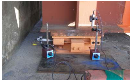
(b) 교량받침의 수직 및 수평변위계
