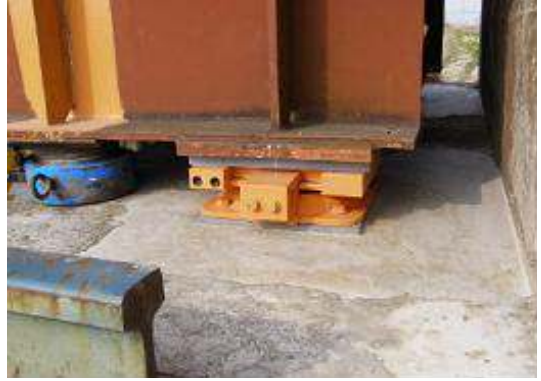
(d) 설치된 교량받침 안정화
