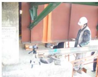
(a) 잭 설치
