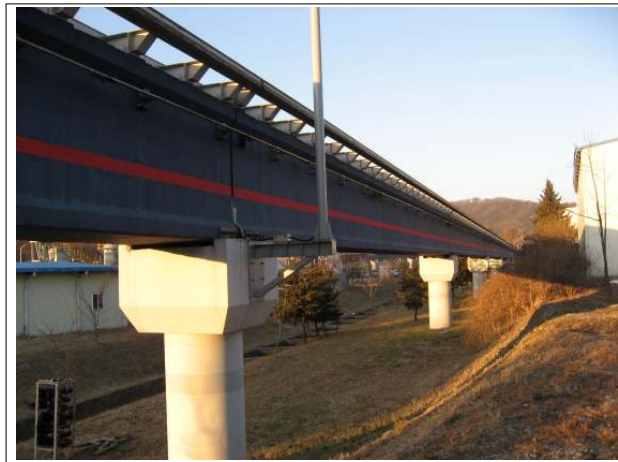
그림1. 자기부상열차용 가이드웨이
