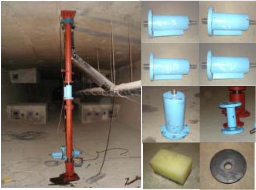
그림 7. 국부진동 저감장치의 설치 모습과 사용된 저감기구들
