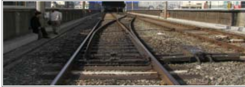
그림 2 Site of conventional line(50kg NH #8 turnout)
