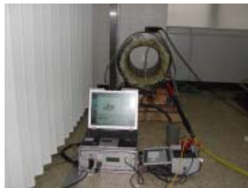
그림 2 부분방전 측정 사진
