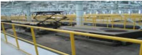
사진7 파이프식 안전난간 및 조립도
