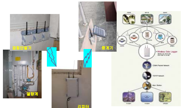
[그림 2-10] 개별난방 세대의 무선검침 시스템 구성
