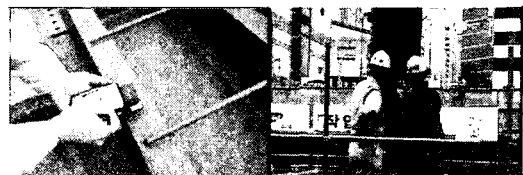
그림 3. 입고 및 양중시 RFID 데이터입력
