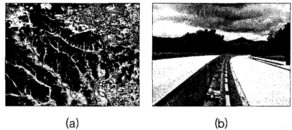
그림 1. 연구대상지역(a) 및 대상 도로 전경(b)
