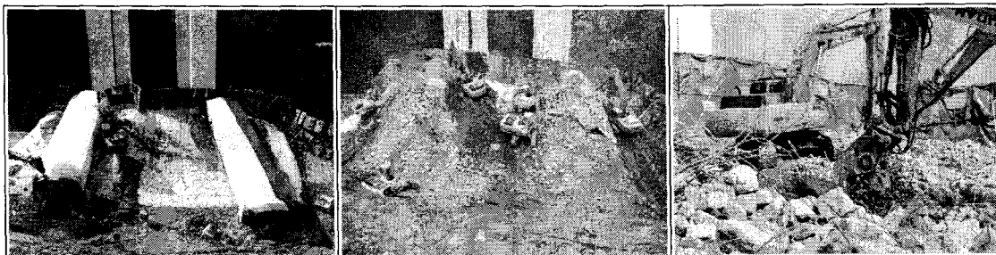
그림 11. 콘크리트파쇄 및 철근분리
