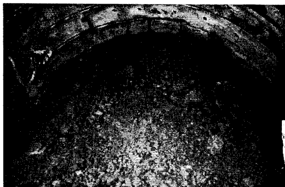
그림 15. OO터널 막장 봉락 전경
