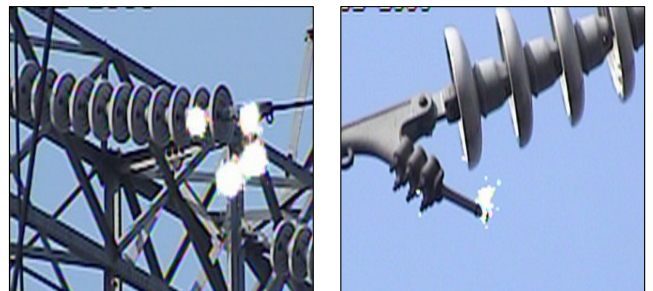
〈그림 3〉 154kV 수전설비 예비가선에서 코로나 발생 현상
