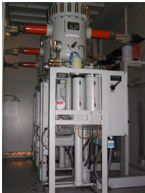
<그림 3> Hydraulic Oil Type의 투입스위치
