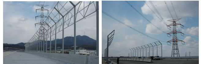
(a) #55~#56 구간 (b) #51~52 구간 그림 6. 저감설비 시공 및 저감량 측정
