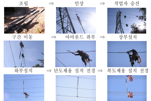
<그림 3> 상간스페이서 설치 순서 및 설치전경
