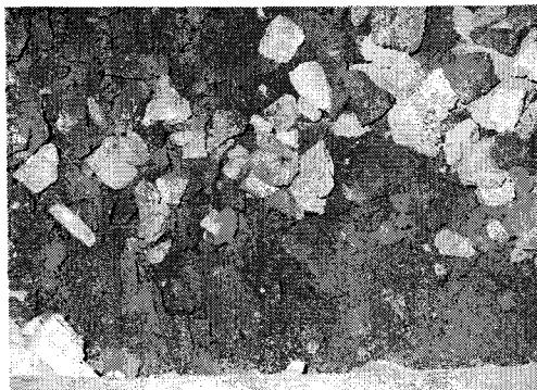
Fig. 3 교량상 자갈도상 궤도의 노후된 상태(세립화 및 고결화)
