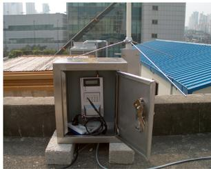
(그림 6) 중계기 설치 모습
